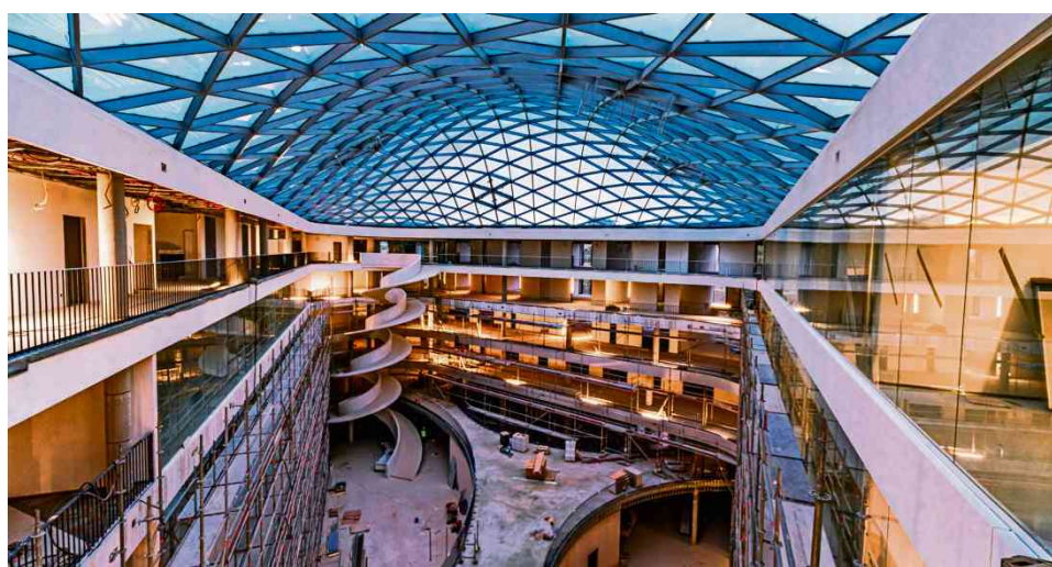
Der Neubau vereint alle Fachbereiche der Fakultät Technik. Foto: DHBW Stuttgart
